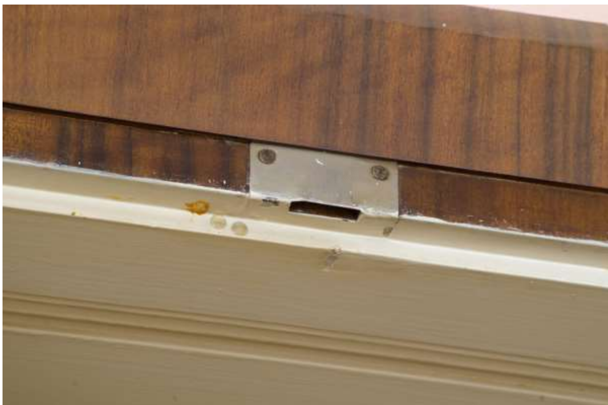
Detail horního protiplechu zástrče
