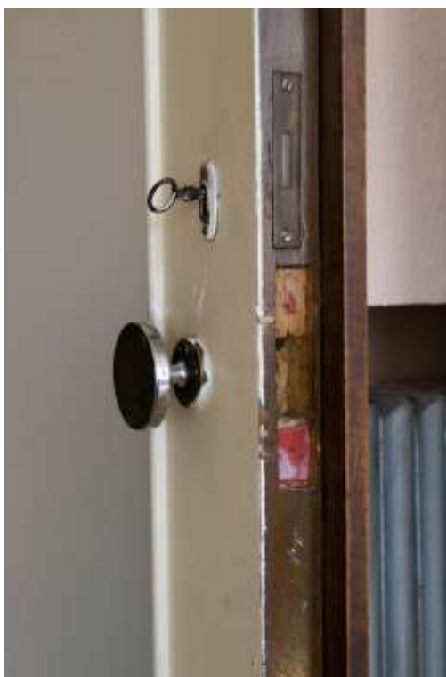
Detail kliky zámku a chybějícího zapadacího mechanismu
