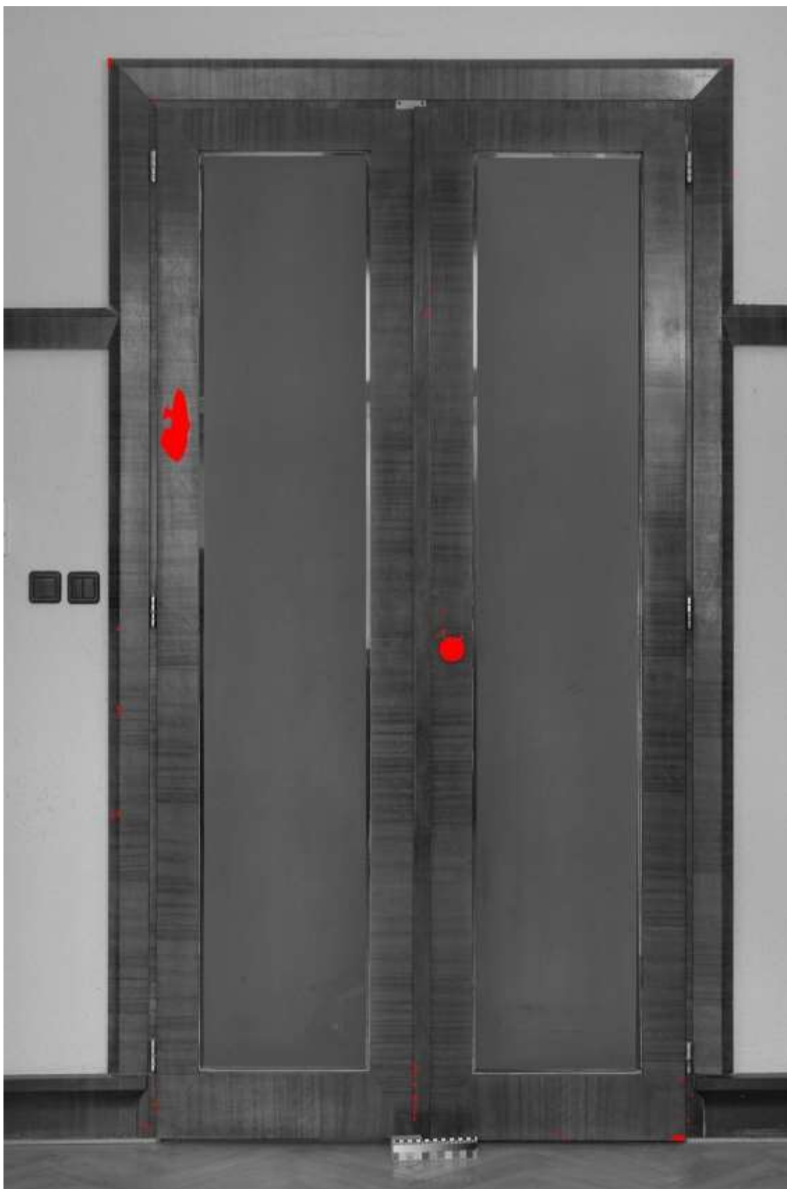
Poškození dveří ze strany jídelny (odřená povrchová úprava a odštípnuté dýhy)
