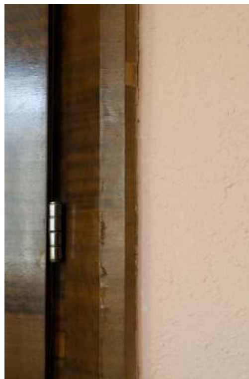
Detail separovaných, chybějících a poškozených dřev na obložkách
